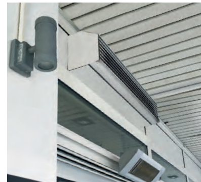
Beheizte Zuluftanlage (Innen- und Außenansicht)
