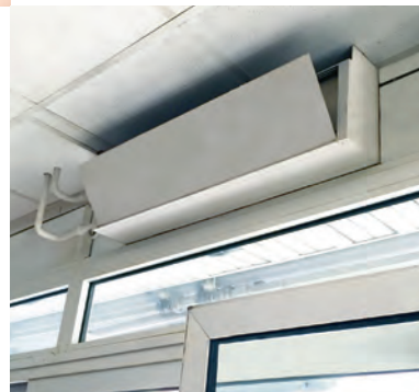
Beheizte Zuluftanlage (Innen- und Außenansicht)
